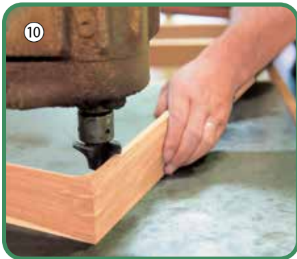
■ 外枠傾斜部をルーター加工
