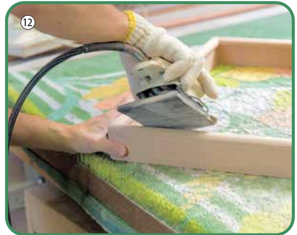
■ 最終仕上げ作業(下地の確認)
